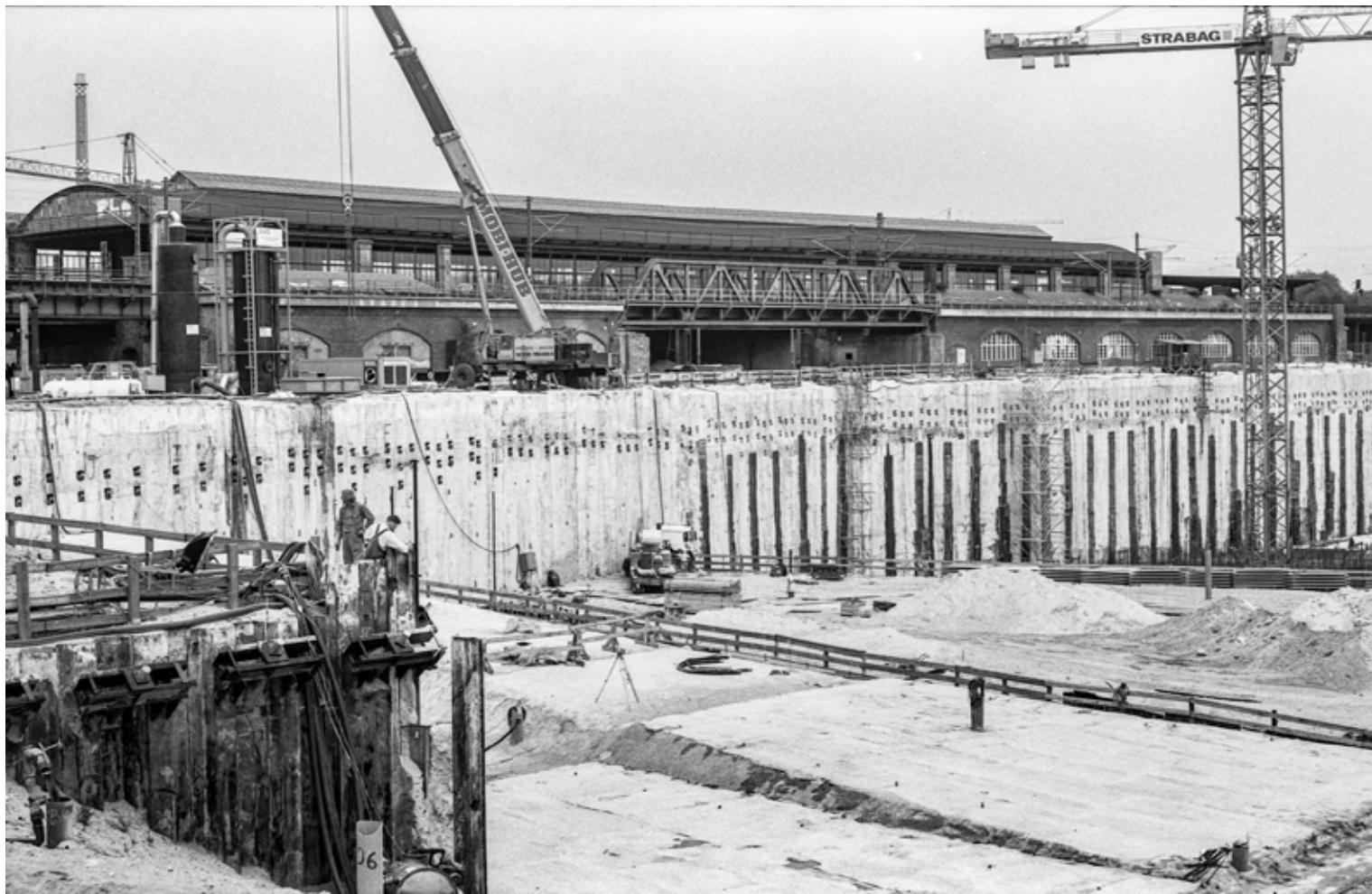
Baustelle Lehrter Stadtbahnhof • 1998
