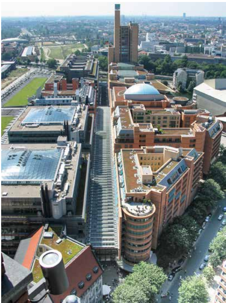
Blick auf Renzo Pianos Block. Im Vordergrund das Glasdach des Einkaufszentrum Potsdamer Platz Arkaden. Hinten ragen die Türme des debis-Hauses in die Höhe. Der linke mit dem grünen Kubus dient nur als Abluftkamin für den Tiergarten-Autotunnel.
